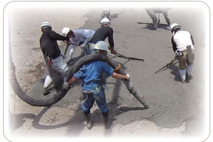
IWA 骨材を使ったリミックスコンの打設
