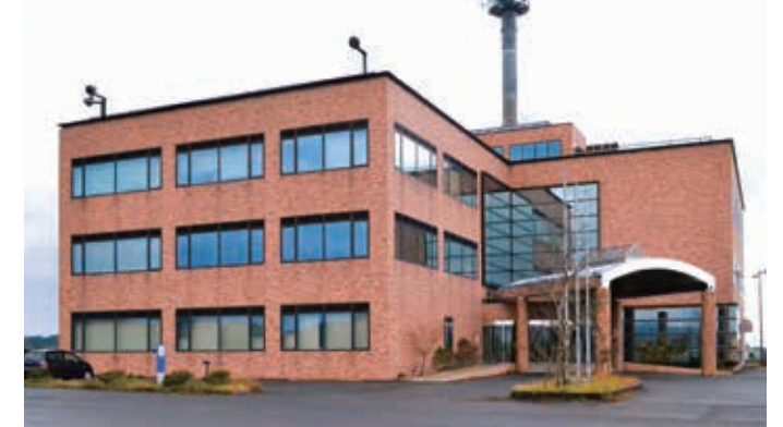
国土交通省 能代河川国道事務所
