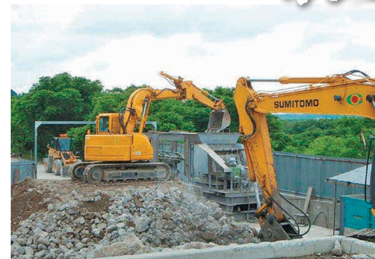
産業廃棄物中間処理施設
