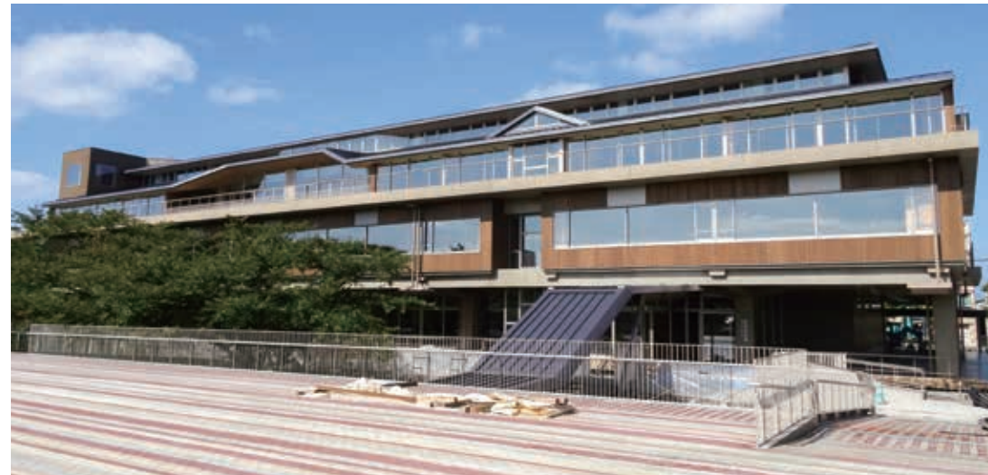
能代市役所新庁舎
