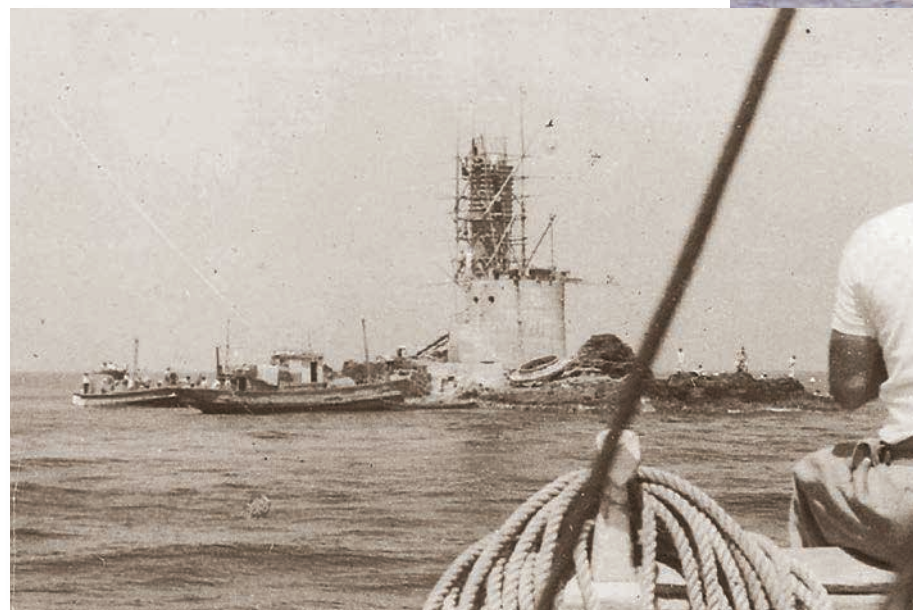
建設中の久六島灯台(昭和33年当時)
