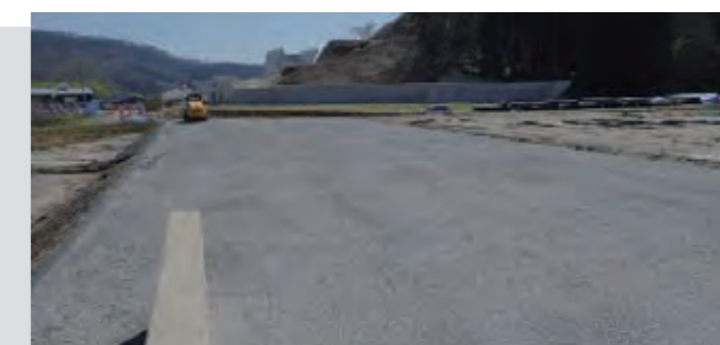
[工事名] 切石地区道路改良工事 (FRC-40使用)
