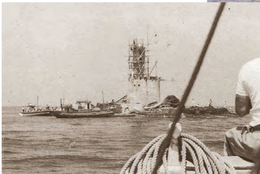
建設中の久六島灯台(昭和33年当時)
