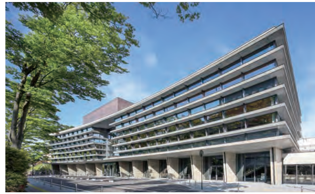
秋田県・市連携文化施設「ミルハス」 竹中・大森・シブヤ・加藤特定建設工事共同企業体施工
