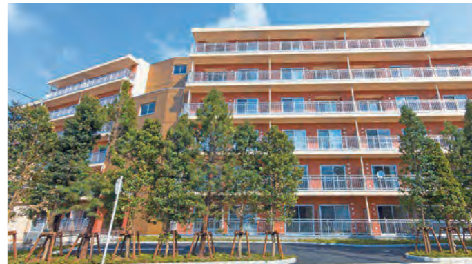
能代市営住宅
